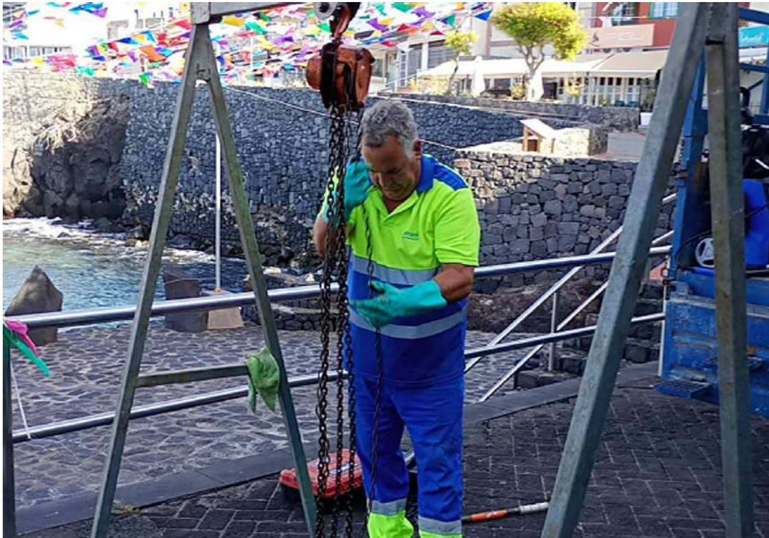
Retirada de toallitas y limpieza de alcantarillado.
