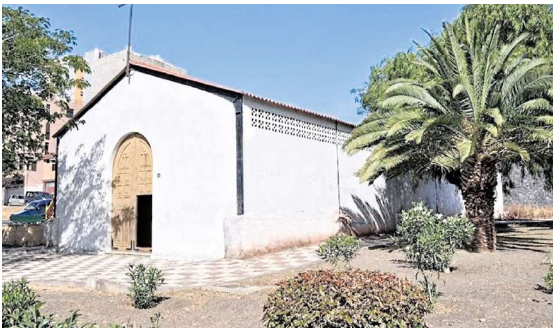
La iglesia de San Gerardo, en La Salud, a punto de ser demolida para crear nuevos usos vecinales
