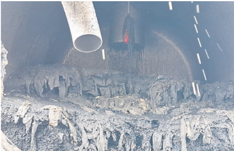
TOALLITAS EN LA RED DURANTE LOS TRABAJOS DE LIMPIEZA DEL ALCANTARILLADO. DA
