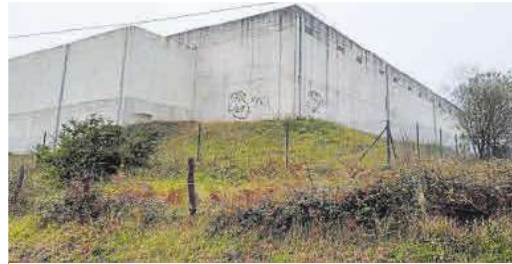
El depósito de agua de La Atalaya, en Pruvia.
